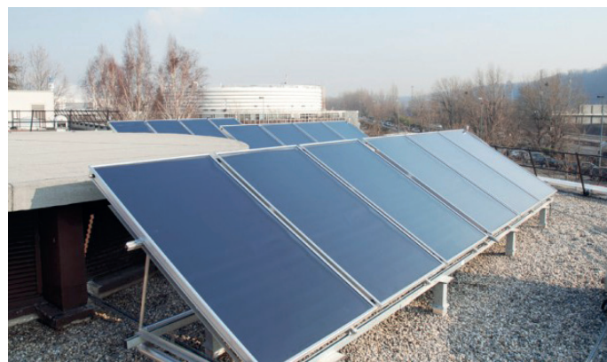
Photo de panneaux solaires thermiques installés sur une toiture (source : le Moniteur).
